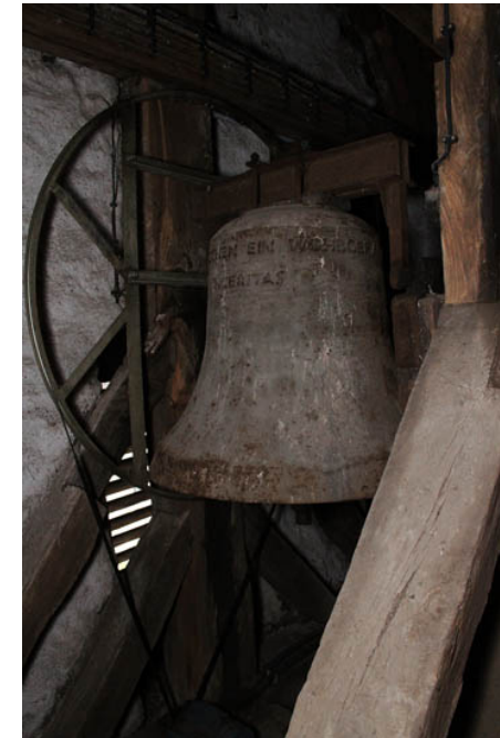
Die kleine Glocke „Sinceritas“ (ca. 600kg, Eisenhartguss, 1956)
